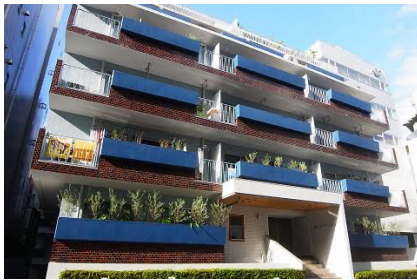
建替え前(金王アジアマンション)
